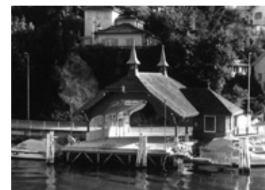
Die Landungsstelle Seeburg 1998 nach der Sanierung und Instandstellung.
