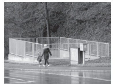
Der geöffnete und kapazitätserweiterte Sandfang des Gerlisbergbachs.
