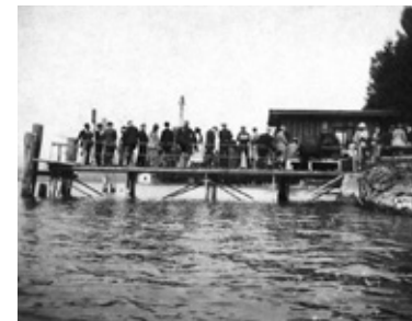
Die Eisenkonstruktion von 1890, noch ohne Wartehaus.
