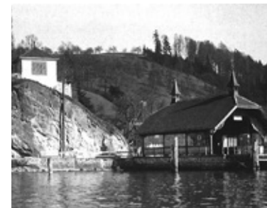
1922 wurde der Felssporn für die neue Gotthardstrasse weggesprengt. Seither ist die Landungsstelle voll erschlossen.
