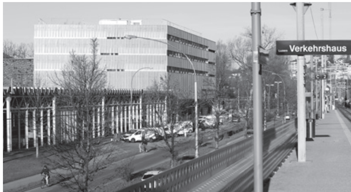
Der Verkehrshaus-Neubau entlang der Haldenstrasse, aufgenommen am 22. März 2023. egg
